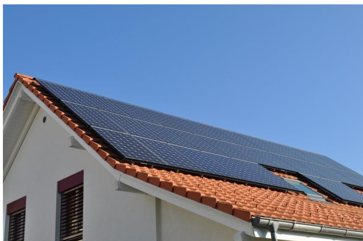
Foto: Dach mit Photovoltaikanlage. Quelle: EKS AG
